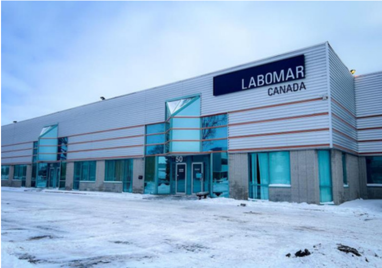
Installation de Labomar Canada à Pointe-Claire, Montréal (Canada)
